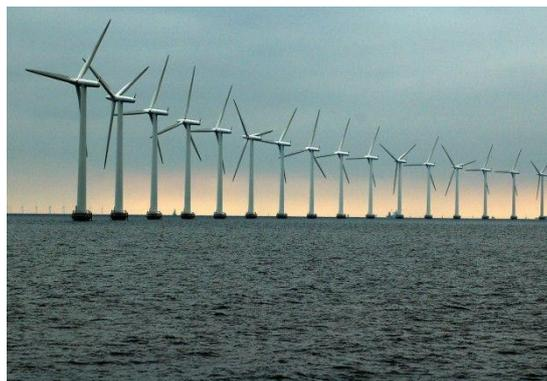
Par son principe de fonctionnement, une éolienne absorbe l'énergie du vent et le rend turbulent, créant ainsi un effet de sillage sur les côtés des éoliennes de plusieurs centaines de mètres qui risque de perturber la navigation de plaisance dans leurs environnements. De plus, la réduction importante du vent juste derrière les éoliennes et l'évacuation de la chaleur peut entraîner des changements de température et faire accentuer le réchauffement climatique.
